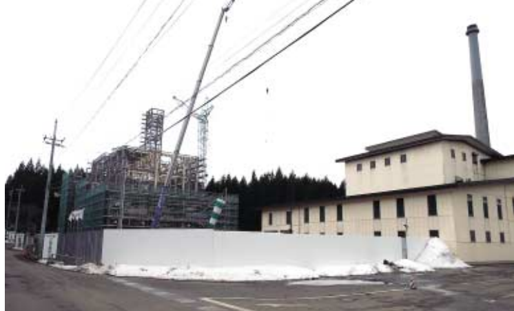
建設中のリサイクルセンター
