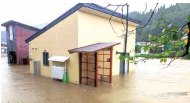
浸水被害に見舞われた住宅(上仏社)
