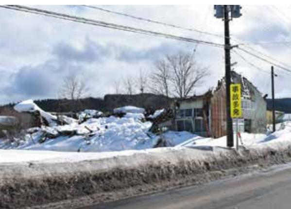
雪で倒壊した旧木工組合の建物
