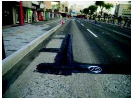
工法例 : サミーシート（流貼り）工法
