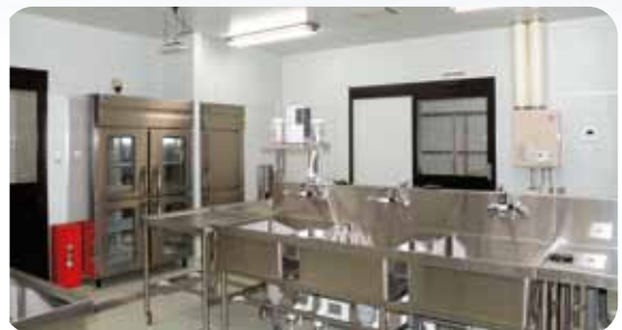
↑ 三槽シンクを備えた下処理室。
