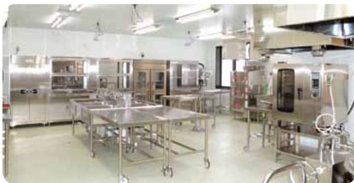
↑ 調理室の内部。床を濡らさずに調理するドライ方式により、衛生的で、安心・安全な給食が提供できます。
