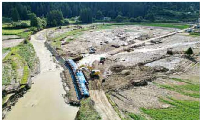
土のうで応急復旧した五反沢川堤防
